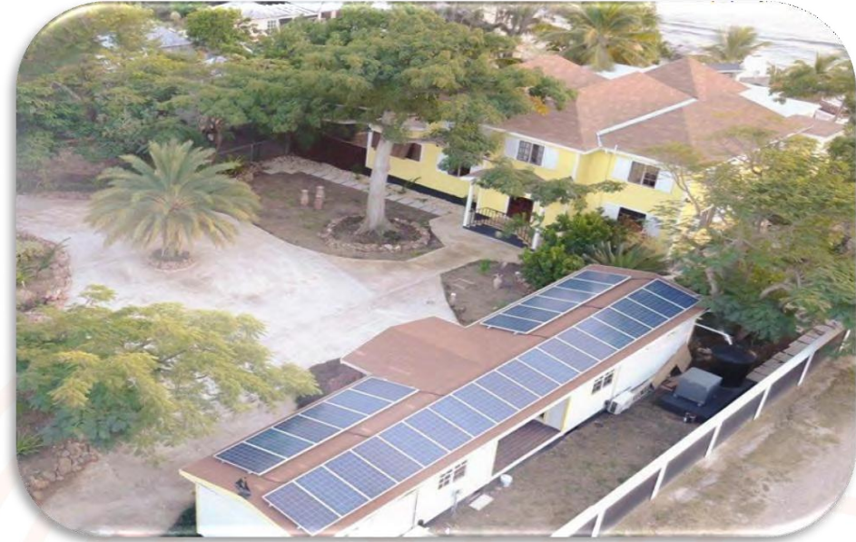
150KW Solar System Antigua 2018
