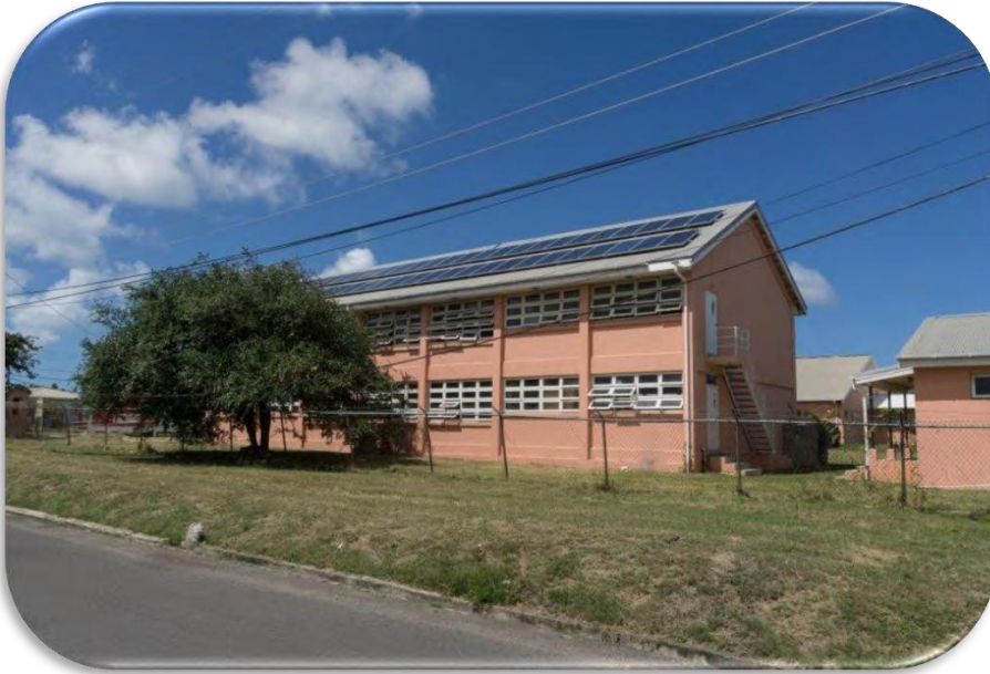
500kw Solar System Antigua year 2017
